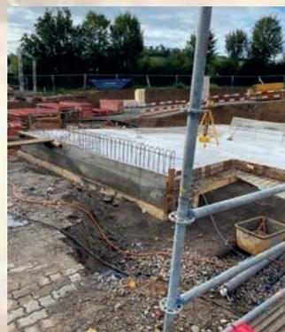
Ende September 2024 wurde nach dem Betonieren der Bodenplatte mit den Schalungsarbeiten für die Wände und Decke des Untergeschosses begonnen.
